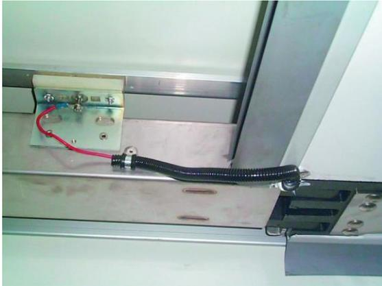
Dieser Schieber muss am Ausgleichsregler montiert werden, nachdem die Frigowall-Tür positioniert wurde, gemäß der Anleitung im Abschnitt „Montage der Schiene“.
