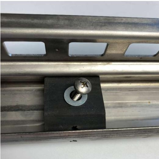
Montieren Sie den Gummistopper.
